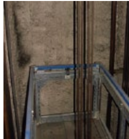
Asbest aan de schachtwanden - ernstig risico voor de gezondheid wanneer men met het asbest in contact komt of het verwijdert.
