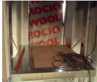
Gefahr des Herausfallens aus dem Fahrkorb
