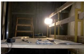
Sichere und stabile Arbeitsbühne mit Geländer zum Schutz gegen Absturz
