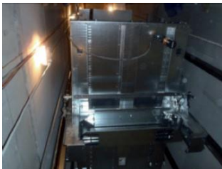
Fahrkorb mit den Seilen verbunden
